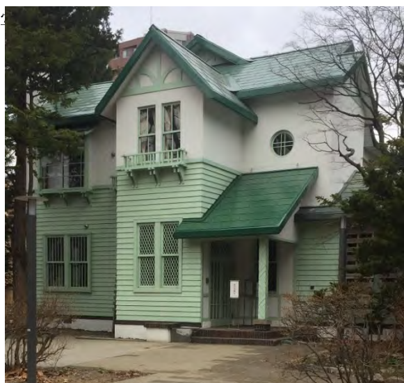
写真_1 改修工事が終了した旧三菱鉱業寮
