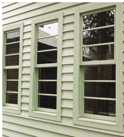
写真_2 復元再生された上げ下げ窓
