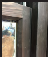
気密パッキンはほとんど隠れてしまい 見えなくなってしまう。
